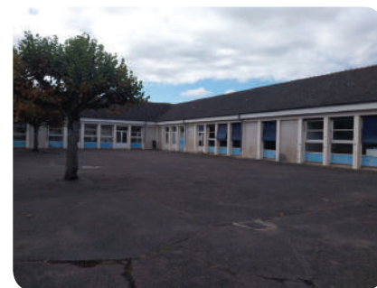
Bâtiment du périscolaire, actuellement vieillissant
